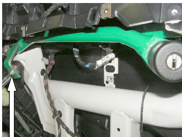
Установить замок, закрутить срывной болт
