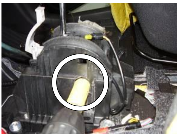
Просверлить отверстие в селекторе под трубу замка
