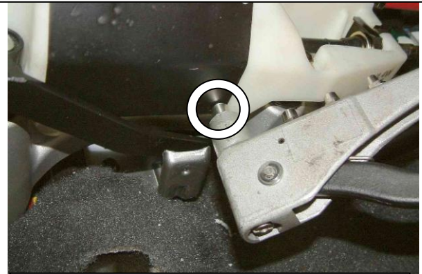
Зафиксировать защиту на селекторе с помощью заклёпок и клёпальника
