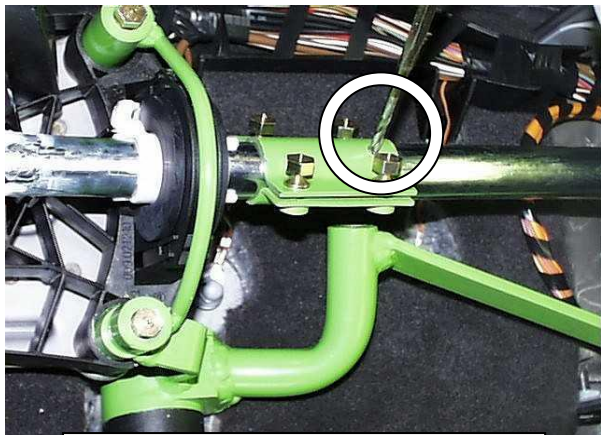
Просверлить отверстие в тяге сквозь отверстие в хомуте
