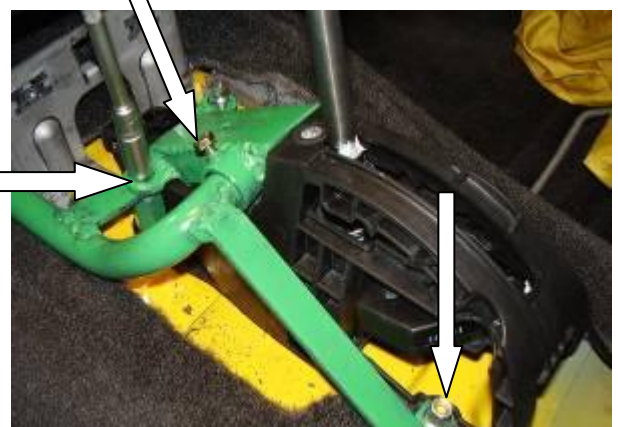
Установить замок на столбик, закрутить 2 срывных болта, зафиксировать защиту на замке срывным болтом Перевести рычаг переключения передач в положение «Р», произвести и проверить блокировку
