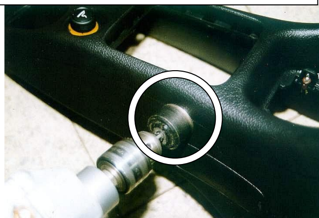
24 Расширить отверстие
