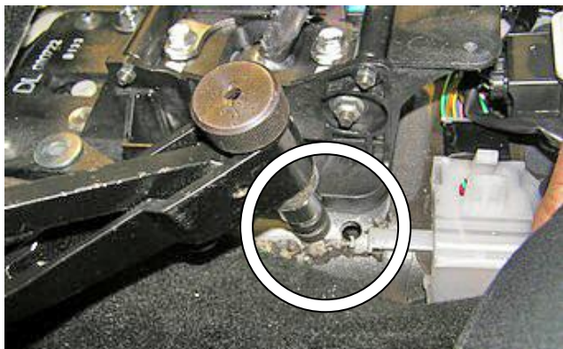
Установить заклёпочные гайки в отверстия
