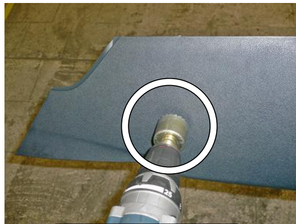
Расширить отверстие
